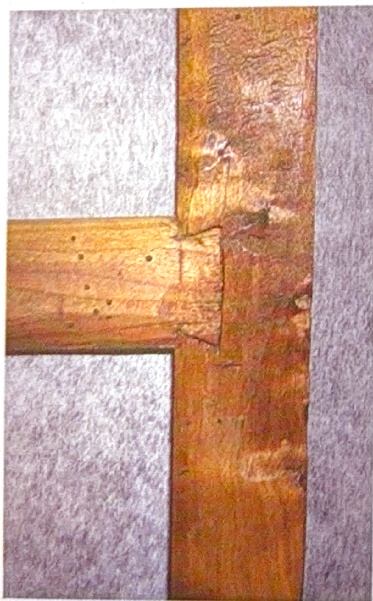
Figg. 5 a, b. Traversa unita al regolo del telaio con incastro a coda di rondine e schema dell'incastro
