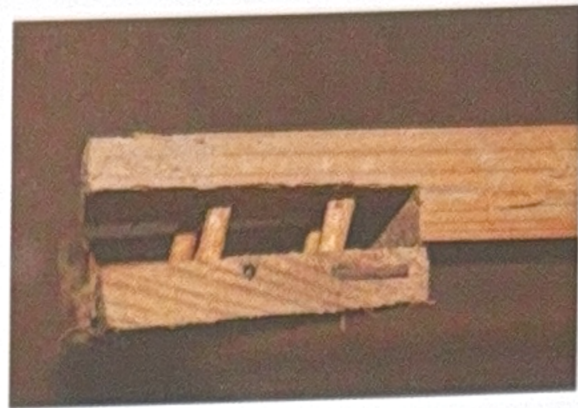
Fig. 7. Unione dei regoli a mezzo legno rafforzata da cavicchi in legno
